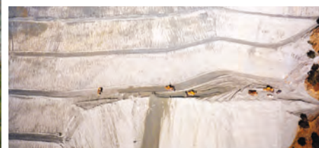
Εικ. 12: Κατασκευή αναβαθμίδων (αριστερά) και χωματοκάλυψη (δεξιά) στην περιοχή του μεταλλείου Αμιάντου
